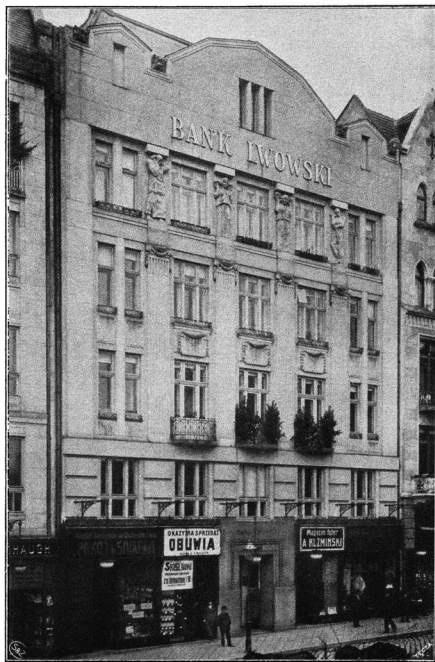
Das neue Direktionsgebäude der Lemberger Bank. Ausgeführt von der Bauunternehmung J. Sosnowski & A. Zacharjewicz, Lemberg.
