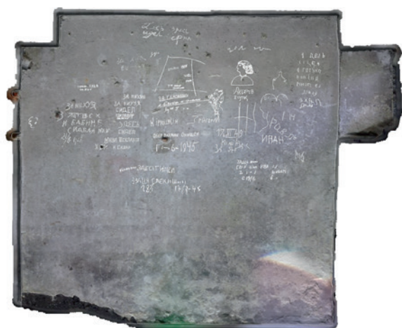
Ryc. 6. Pomieszczenie -1.9, ściana 1 (północna) – wizualizacja skanowania 3D przy użyciu skanera laserowo-optycznego firmy FARO, model Focus S 150, z laserowym pomiarem odległości oraz pozyskaniem obrazu w trybie szerokiego zakresu dynamicznego (HDR) wraz z naniesionymi przerysami inskrypcji, napisów i rysunków; oprac. Robert Kulig
