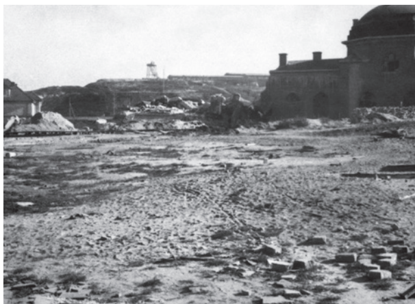
Ryc. 8. Ruiny domu przedpogrzebowego, 1944; w zbiorach IPN, sygn. IPNKR-2-15-4-136
