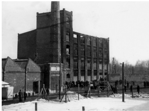
Widok radogoskiego więzienia po spaleniu, 1945; w zbiorach MTN, sygn. I-4615
