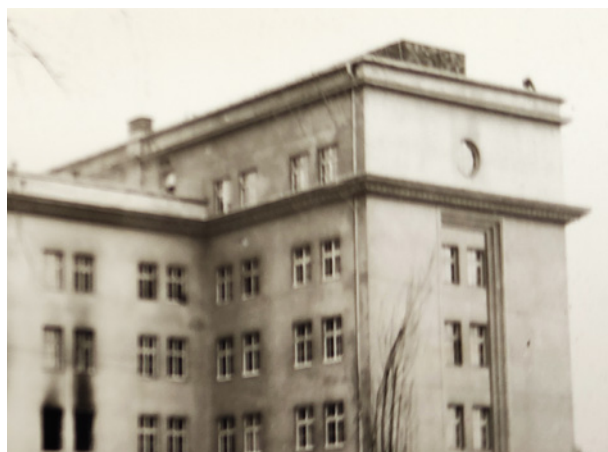
Zamurowana na polecenie Niemców dekoracja rzeźbiarska gmachu, stan z 1948 r.; w zasobie AAdK, Zbiór fotografii, sygn. ZF 5053
