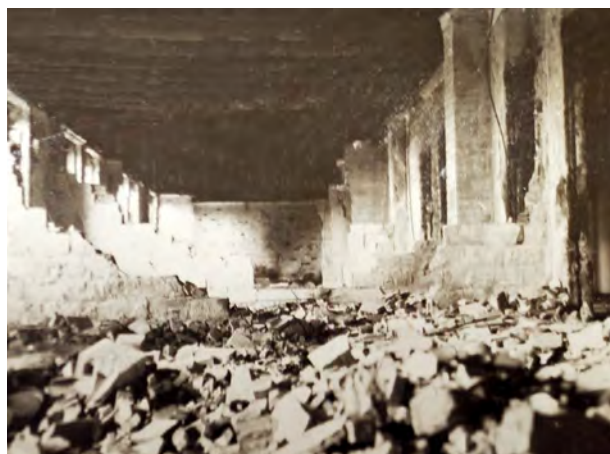
Budynek Śląskiego Seminarium Duchownego, zniszczenia refektarza dużego na skutek pożaru, stan w 1948 r.; w zasobie AAdK, Zbiór fotografii, sygn. ZF 368
