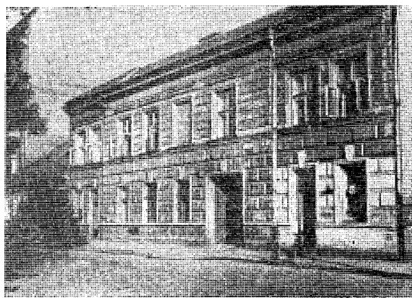
Przebudowany dom przy ul. Krupniczej nr 25, gdzie 15 stycznia 1869 r. urodził się Stanisław Wyspiański.
