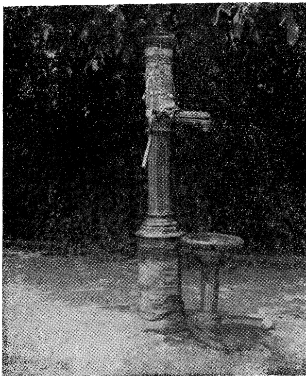
Ulica Kazimierza Wielkiego 119 Pompa uliczna ulegająca powolnej dewastacji
