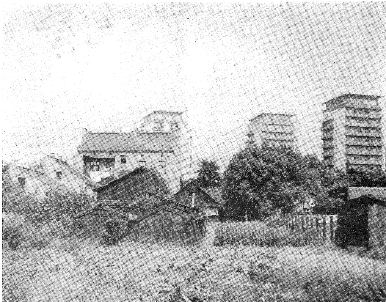
Zmiany krajobrazu przy alei Grottgera. Zagospodarowanie terenu widoczne na pierwszym planie, ustępuje zabudowie wysokiej
