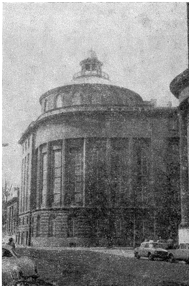
Bursa dla młodzieży rzemieślniczej i przemysłowej im. ks. M. Kuznowicza przy ul. Skarbowej 2. W narożniku na 1-szym piętrze mieści się sala teatralna, obecnie Teatr Lalki i Aktora Groteska. Stan obecny
