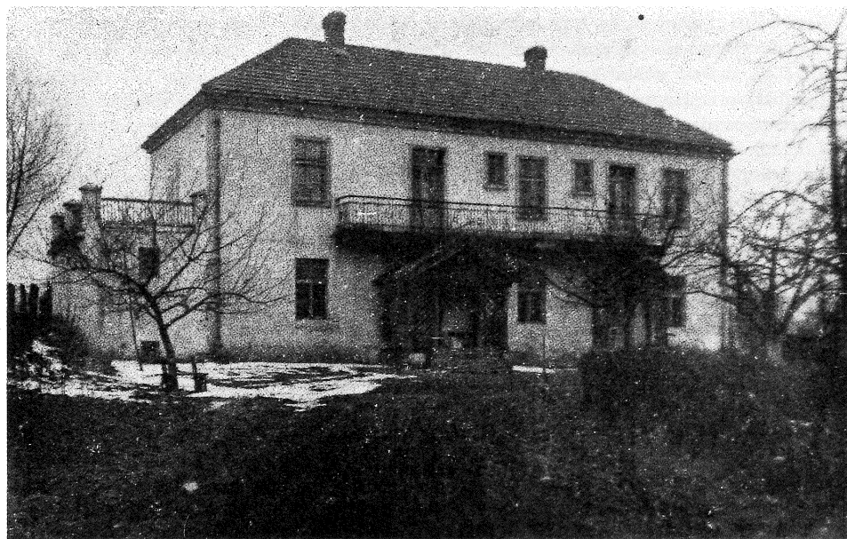
7. Nieistniejąca „Kobiółka” — elewacja frontowa, ul. Sobótka, zdjęcie z ok. 1935 r., fot. ze zbioru Zofii Łaszczynskiej.
