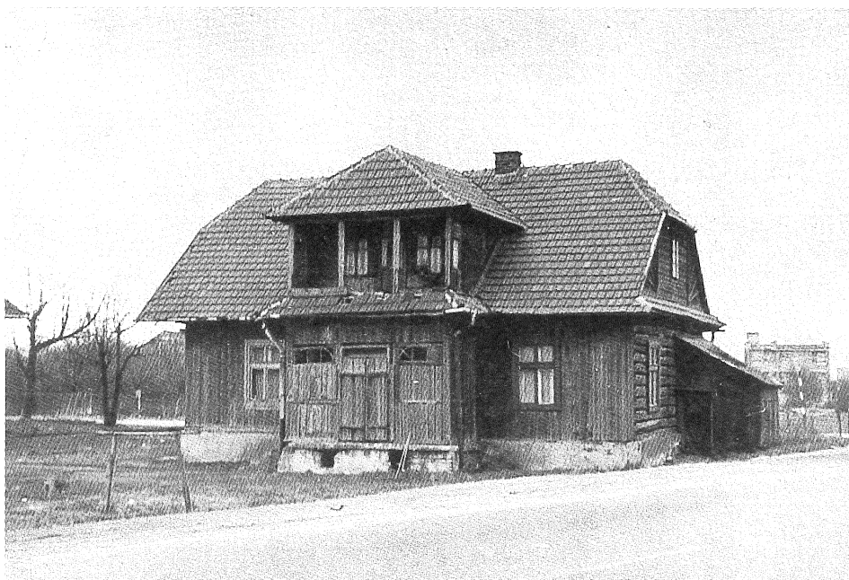
7. Dom drewniany przed rozbiórką, ul. W. Helmana 60. Fot. Wydział Rozbudowy Podgórze, 1976
