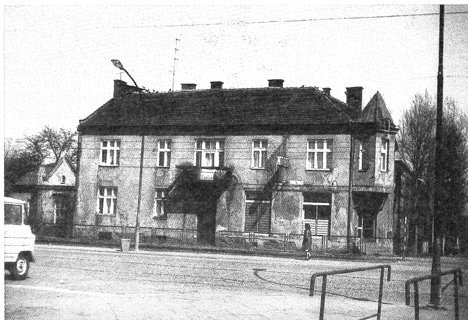
10. Kamienica, ul. Wielicka 112, wyburzona w 1984 r. Fot. H. Świątek, 1978
