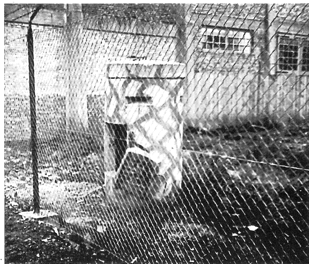
6. Betonowy bunker na terenie obozu przy ul. Lipowej 4, przeznaczony do obrony straży obozowej na wypadek nalotów lotniczych. Często karą za rzekome uchybienia w fabryce lub obozie było zamykanie w nim więźniów na kilka godzin.
