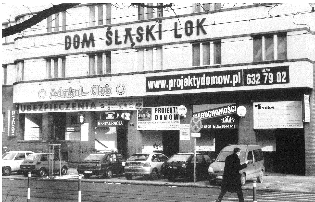
17. Fasada budynku od ul. Królewskiej 1, stan z końca 2002 r.
