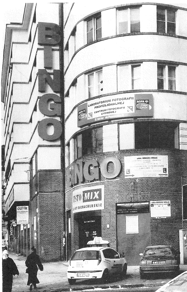
18. Narożnik Domu Śląskiego z reklamami komercyjnych użytkowników gmachu
