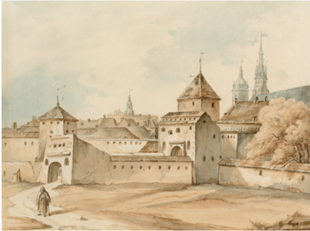
Brama Nowa od wschodu według stanu z początku XIX w. , mal. Jan Kanty Wojnarowski, Kraków, 1840, akwarela; w zbiorach MK, nr inw. MHK-1060/VIII
