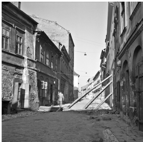
Fragment ul. Józefa z masywnymi belkami wspierającymi ścianę jednej z kamienic, pierwsza połowa lat sześćdziesiątych XX w.; w zbiorach MK, nr inw. MHK-9700/N/8
