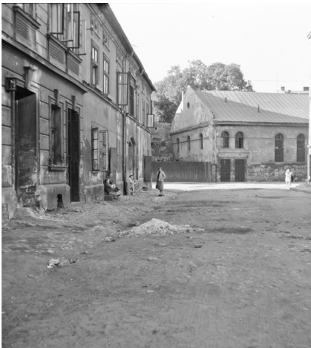
Fragment ul. Kupa przy skrzyżowaniu z ul. Warszawiera, w głębi synagoga Kupa, przełom lat pięćdziesiątych i sześćdziesiątych XX w.; w zbiorach MK, nr inw. MHK-9699/N/2
