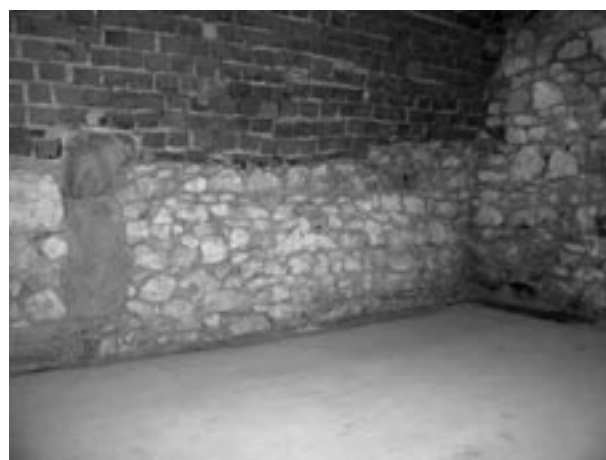
Ryc. 12. Kamienny watek elewacji frontowej domu z fazy III, widziany od strony przedproży w południowej komorze. Fragment portalu z piaskowca w dawnym wejściu; ceglano sklepienie z wieku XIV, fot. L. Holcer
