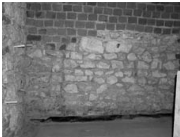
Ryc. 7. Kamienny wątek elewacji frontowej widziany od strony przedproży w południowej komorze. Cezura pomiędzy narożnikiem obecnego Pałacu Spiskiego, a drugim domem w obrębie pałacu „Pod Krzysztoforą”, fot. Ł. Holcer
