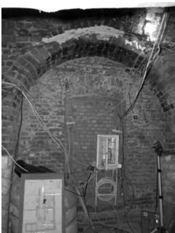
Ryc. 27. Ceglana arkada rozpięta między oplaszczowanym narożnikiem obiektu XIII-wiecznego, a zachodnią elewacją budynku wzniesionego w IV fazie
