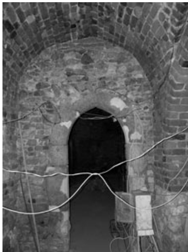
Ryc. 32. Portal w kamiennym wątku zachodniej, zewnętrznej elewacji budynku z IV fazy. Wyżej późniejsze sklepienie z 2 połowy XIV wieku, fot. Ł. Holcer
