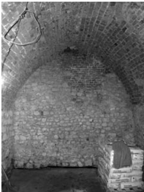
Ryc. 30. Północna ściana komory północnej przedproży. W kamiennym wątku zamurowany otwór dawnego okna otwartego w kierunku ul. Sławkowskiej. Ceglane sklepienie nieco wyostrzone w kluczu, fot. Ł. Holcer
