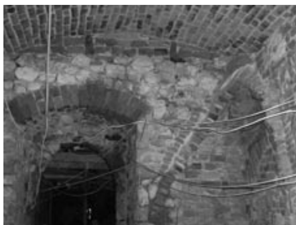
Ryc. 11. Zachodnia ściana w pomieszczeniu z fazy IV. Odcinkowe nadproże nad wejściem i fragment ceglanoego wiatku usytuowanego na dawnej odsadzce. W narożniku pozostałości późniejszej kapy piecowej, fot. L. Holcer
