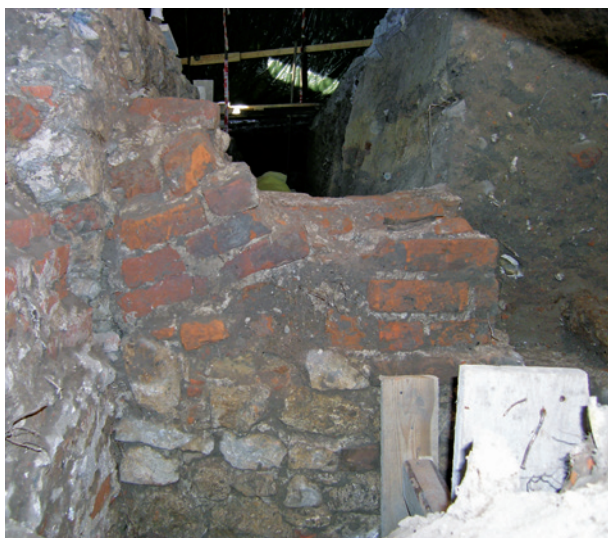
Ryc. 25. Przedproże północne, ściana wschodnia. Górny fragment północnego muru oporowego dostawionego do elewacyjnej ściany przedproża, przy dawnym zejściu z Rynku. Na koronie kamiennego muru pozostałości ukośnie biegnącego, ceglanego sklepienia, fot. L. Holcer
