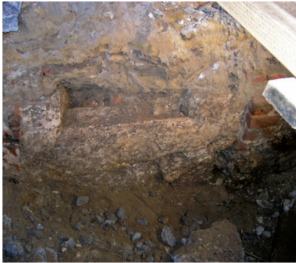
Ryc. 27. Przedproże północne, ściana wschodnia, drugie okno od strony północnej. Dolna, zachowana część kamiennego obramienia okna. W węgarach i parapecie szeroka faza. Płaszczyzna kamieniarki oraz zamurówka pod parapetem, wyraźnie cofnięte w stosunku do lica ściany, fot. Ł. Holcer
