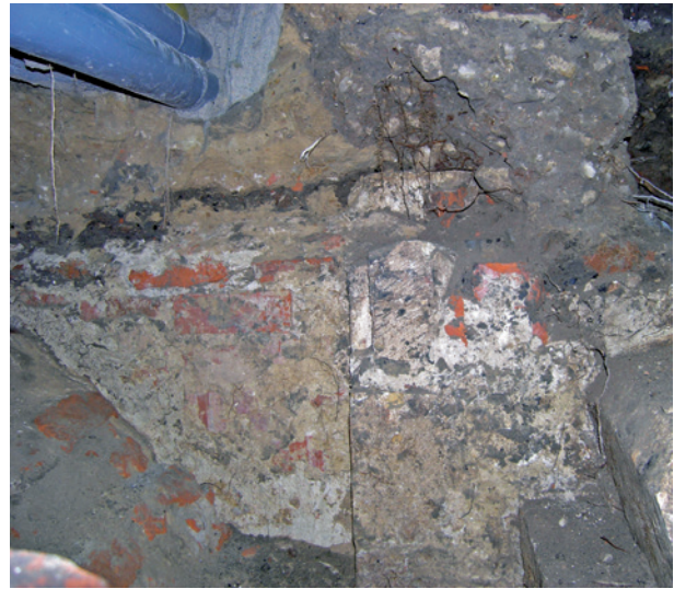
Ryc. 28. Przedproże południowe, ściana wschodnia. Północne ościeże dawnego okna (drugie od strony południowej). Na ścianie lunety ustawione w pasze sklepienia, zachowane fragmenty cienkiego tynku gotyckiego (z lewej). Z prawej fragment zachowanej, dolnej części kamieniarki okiennej, ukośnie osadzonej w stosunku do lica ściany, fot. Ł. Holcer
