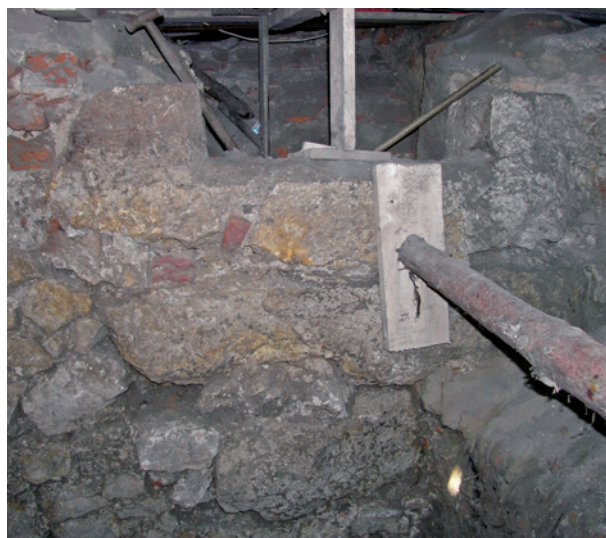
Ryc. 26. Przedproże północne, ściana wschodnia. Dolna część zachowanej kamieniarki okiennej w pierwszym oknie od strony północnej. Przy węgarach uzupełnienia z grubej, palcowanej cegły. Poniżej parapetu wążek kamienniej ściany przemurowany. Fazowane węgary i parapet wykonano z monolitycznego bloku wapienia, fot. L. Holcer
