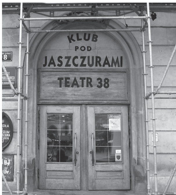
Oślonięta rusztowaniami kamienica „Pod Jaszczurami” przy krakowskim Rynku Głównym – miejsce wielu historycznych wydarzeń, dziś znana głównie z słynnego w całym kraju studentkiego Klubu Pod Jaszczurami (grudzień 2007), fot. A. Florkowska
