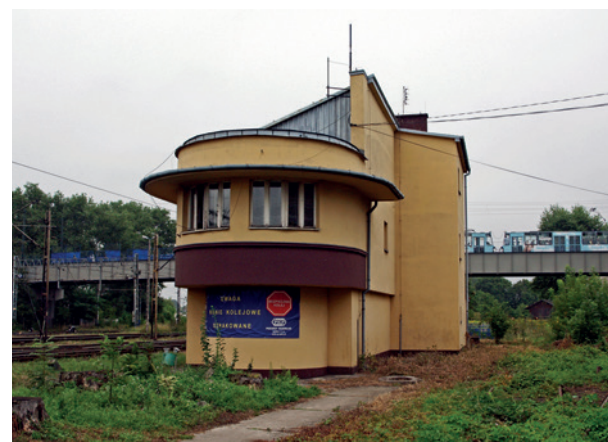
Wybudowana w 1942 r. była nastawnia KZ 2 we wschodniej części Dworca Towarowego. Przebudowa z lat 90. XX w. (otynkowanie ścian i nowy dach) zatarła częściowo pierwotne cechy stylistyczne obiektu, fot. D. Lulewicz, 2009
