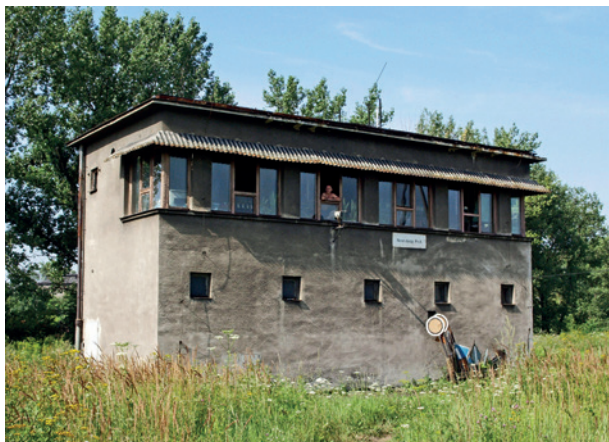
Nastawnia Pr A na stacji rozrządowej Kraków Prokocim Towarowy, reprezentująca uproszczony typ budownictwa kolejowego z czasów II wojny światowej, fot. W. Dykas, 2009
