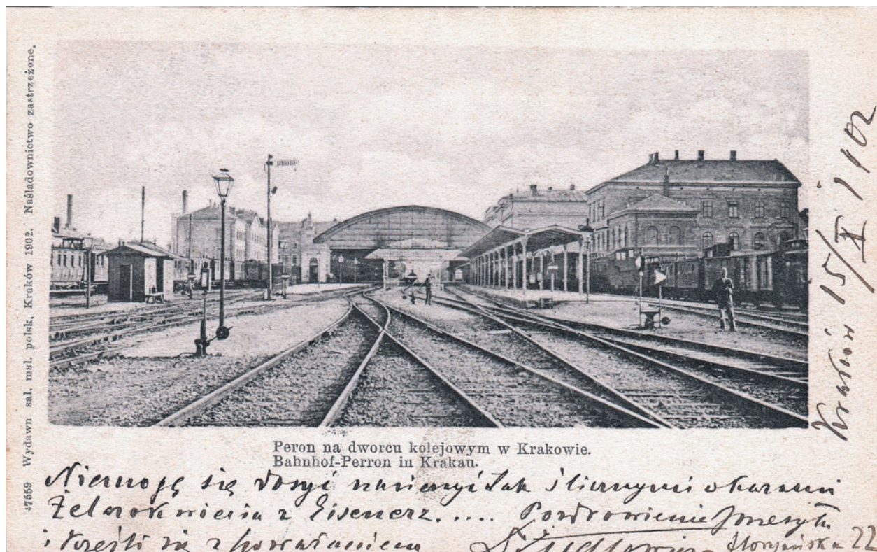
Dworzec Główny widziany od północy. Widoczna, przeszklona hala peronowa rozebrana w roku 1935, po uruchomieniu linii kolejowej do Tunelu oraz semafor kształtowy typu austriackiego (z ażurowym ramieniem), pocztówka, 1902; wł. MHK, nr. inw. MHK 1485/K/VIII
