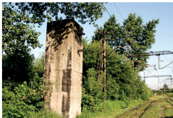
Jeden z dwóch zachowanych na terenie stacji Kraków-Płaszów bloków betonowych służących do tarasowania torów, postawionych przez Niemców przed końcem wojny, fot. W. Dykas, 2009
