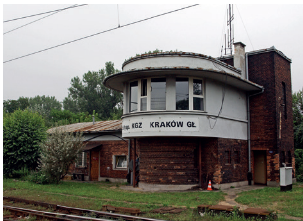
Wybudowana około 1942 r. dawna nastawnia dysponująca KT A, obecnie KGZ, przy zachodniej głowicy Dworca Towarowego w Krakowie. Widoczny brak górnej kondygnacji nad lewą częścią budynku, fot. D. Lulewicz, 2009
