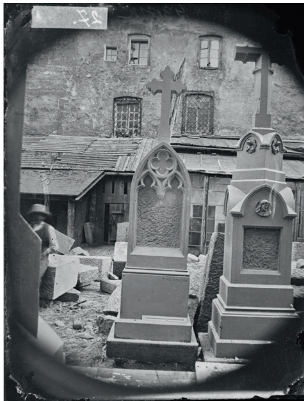
Ryc. 3. Podwórkó kamienicy Bonеровskiej z nagrobkami autorstwa Fabiana Hochstima i pracownią Kriegera (w głębi), fot. zakład Ignacego Kriegera, lata sześćdziesiąte lub siedemdziesiąte XIX w., negatyw kolodionowy; w zbiorach MK, nr inw. MHK-4223/K
