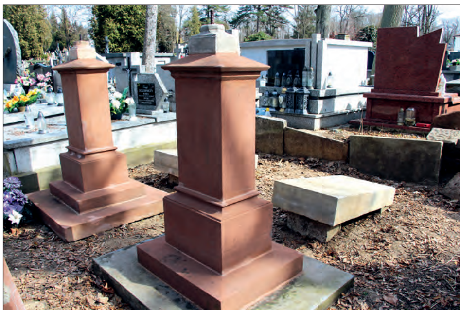
14. Kwatera grobowa rodziny Kiebaczych po pracach renowacyjnych; 2023; fot. Paweł Grzesik
