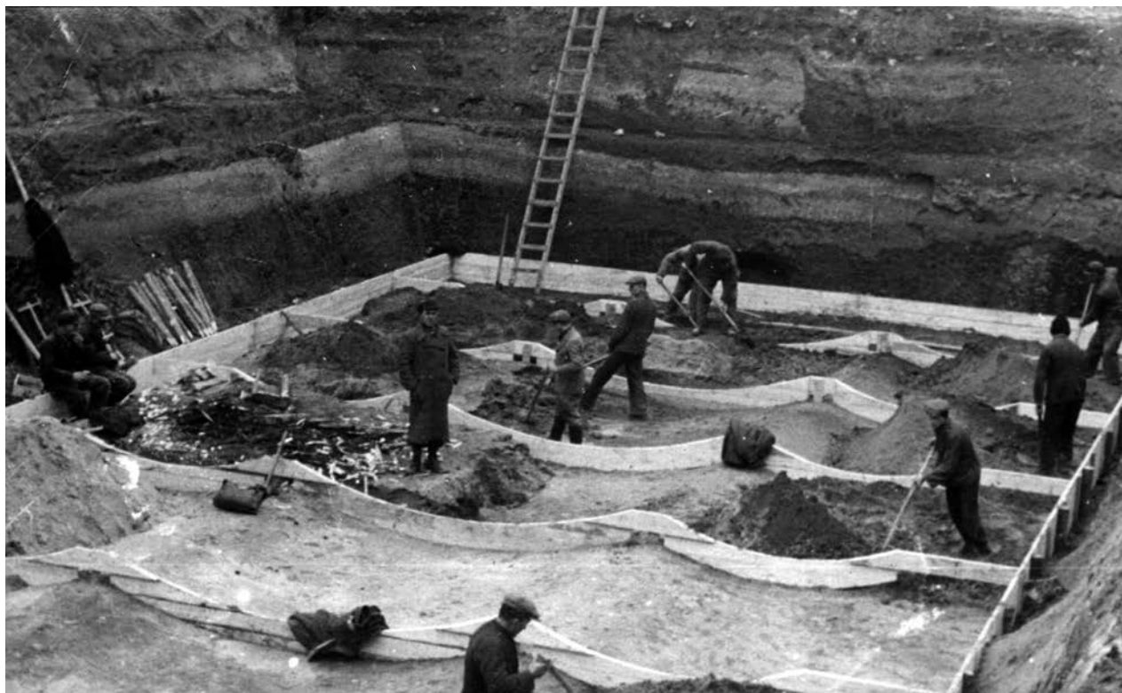
15. Prace przy budowie zbiornika przeciwpożarowego na Rynku Głównym w Krakowie, 1942/1943. Fot. ze zbiorów MAK
