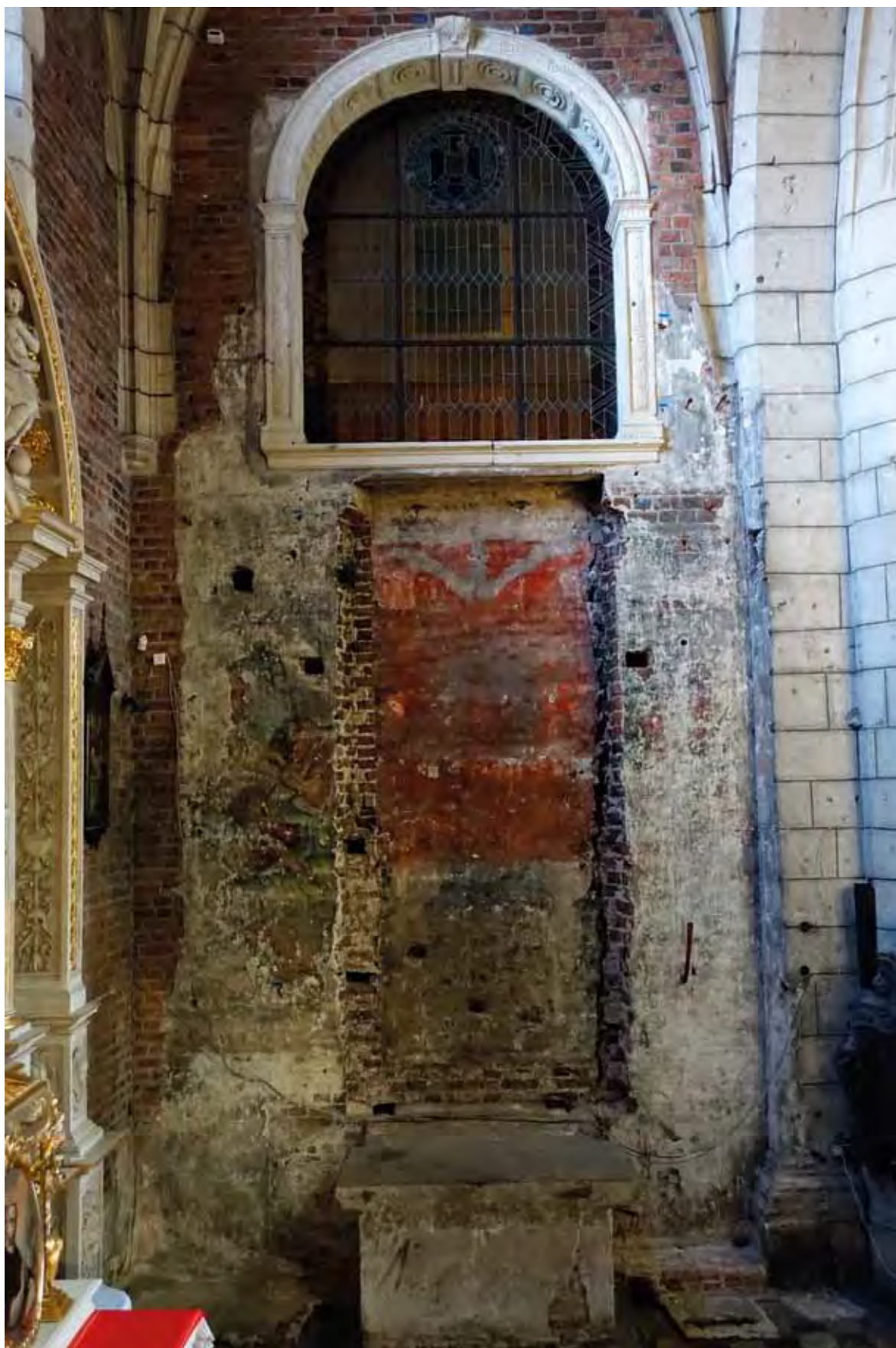
13. Kościół parafialny pw. Bożego Ciała, obramienie okienne po konserwacji i relikw ołtarza z lat 1612–1644 przy wschodniej ścianie nawy północnej, 2019. Fot. Krystyn Kozieł
