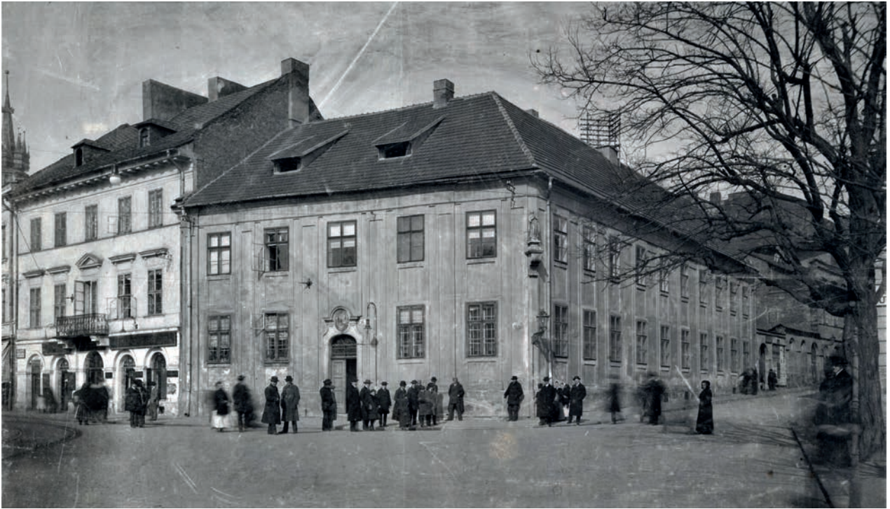
1. Siedziba Archiwum Aktów Dawnych Miasta Krakowa przy ul. Siennej 16, ok. 1910. Archiwum Narodowe w Krakowie (dalej: ANK), Zbiór fotograficzny, sygn. 29/670/11079
