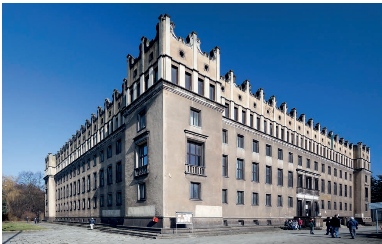
2. Budynek „Z” – Zarządu Centrum Administracyjnego, widok elewacji zachodniej i południowej. Fot. Igor Stanisławski
