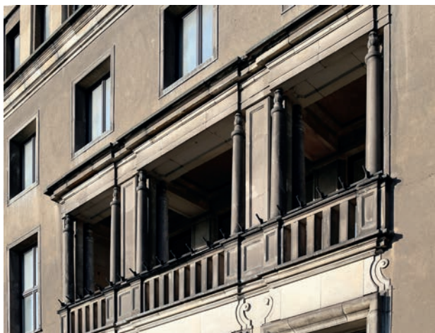
13. Galeria nad głównym wejściem Centrum Administracyjnego. Fot. Igor Stanisławski
