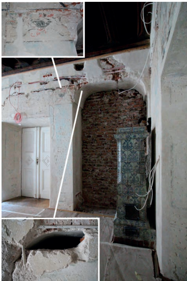
5. Widoczne relikty tynków z pobiałami i śladowo zachowanym malowidłem z XVII w. na styku ze stropem na ścianie północnej. Na nich współczesne zaprawy wyrównawcze, 2020. Fot. Katarzyna Feć-Sfora.
