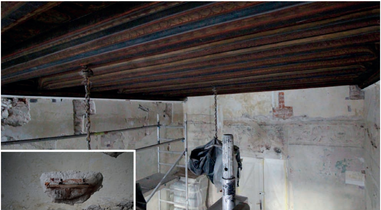
10. Odkrytki architektoniczne: poziome deseczki osadzone w ścianie południowej i północnej można wstępnie łączyć z elementami konstrukcji służącej do zamocowania płaskiego sufitu, który osadzono w XVIII w. poniżej manierystycznego stropu belkowego, 2020. Fot. Katarzyna Feć-Sfora
