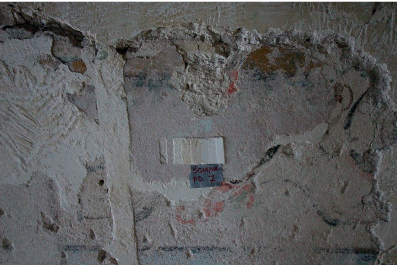
2. Widoczna sonda schodkowa pokazująca warstwy technologiczne powyżej malowidła z XIX w. oraz odsłonięte dwie dekoracje malarskie na ścianie południowej – starsza z fryzem z motywem groteski z 2. połowy XVIII w. i przysłaniająca ją empirowa z początku XIX w. Granica występowanie dekoracyjnych warstw malarskich jest miejscem dawnego usytuowania sufitu, przysłaniającego od XVIII do prawdopodobnie początków XX w. strop belkowy. Powyżej osiemnastowiecznego fryzu groteskowego widać współczesne tynki przysłaniające przewody instalacyjne, 2020. Fot. Katarzyna Feć-Sfora
