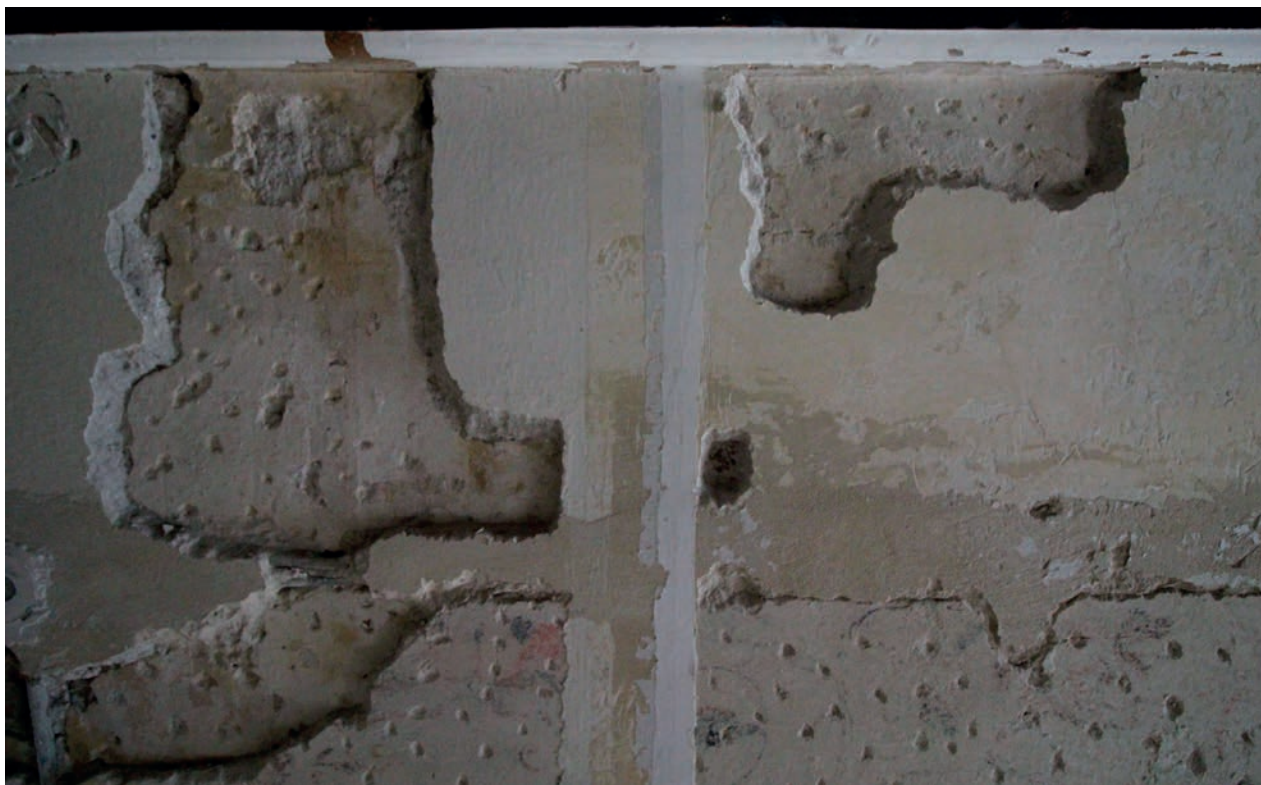
5. Widoczne relikty tynków z pobiałami i śladowo zachowanym malowidłem z XVII w. na styku ze stropem na ścianie północnej. Na nich współczesne zaprawy wyrównawcze, 2020. Fot. Katarzyna Feć-Sfora.
