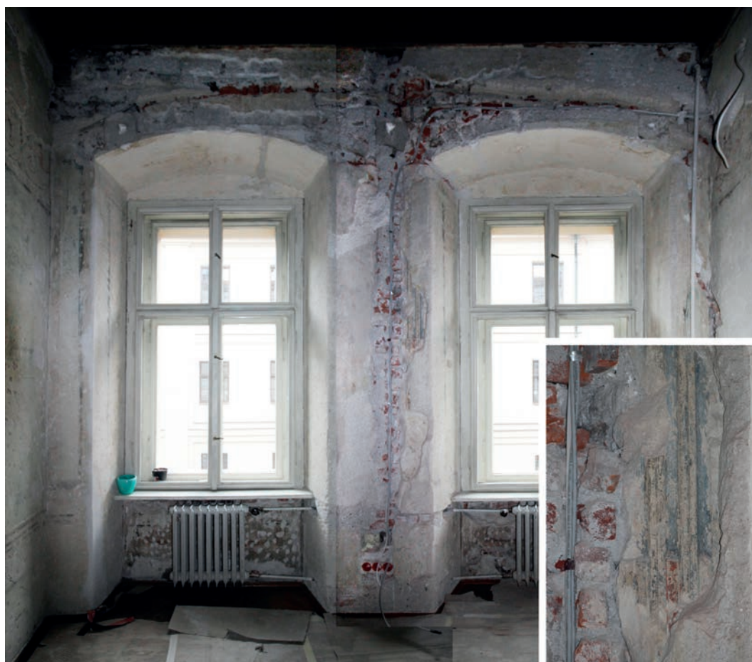
8. Widoczny odkryty relikw polichromowanej kolumny międzyokiennej, 2020. Fot. Katarzyna Feć-Sfora
