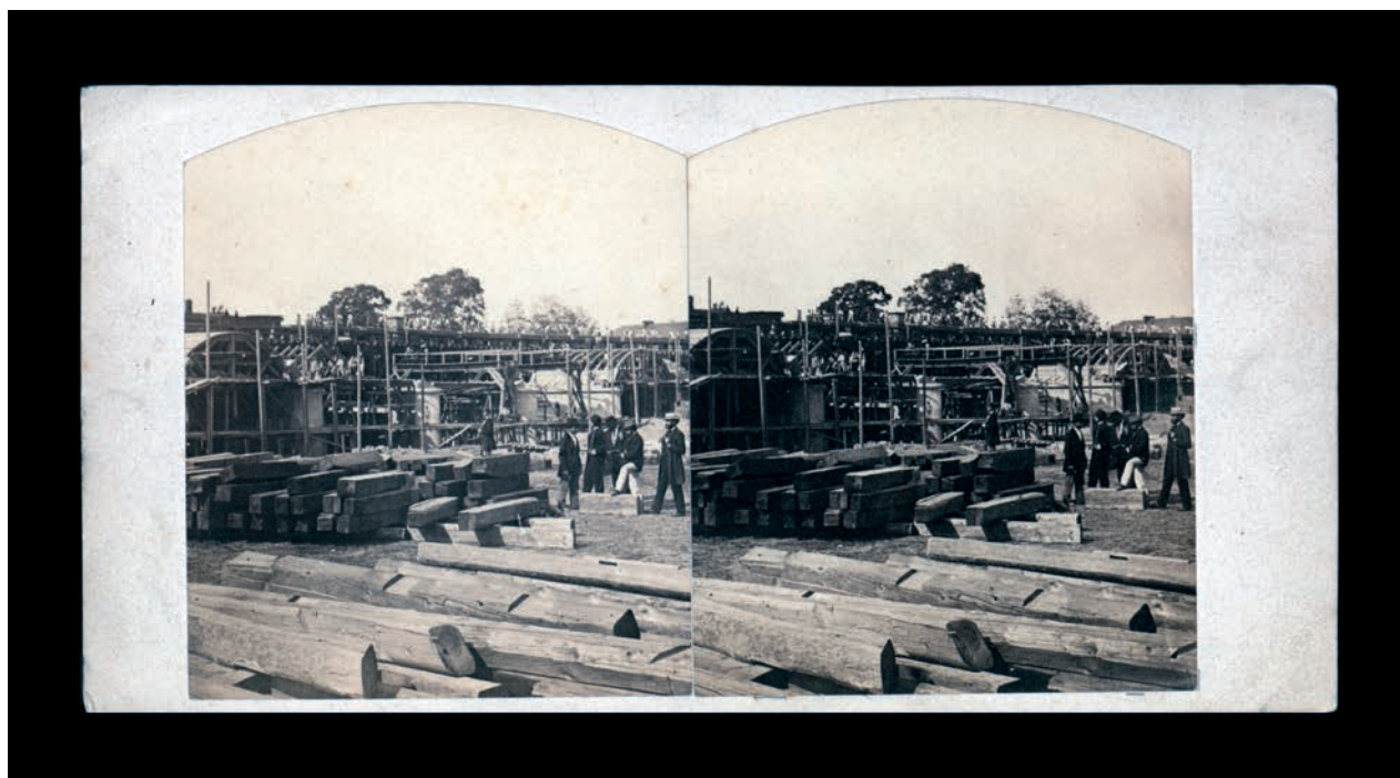
1. Budowa mostu kolejowego nad Starą Wisłą, fot. nieznany, 1862, odbitki albuminowe. ANK, sygn. 29/670/3889
