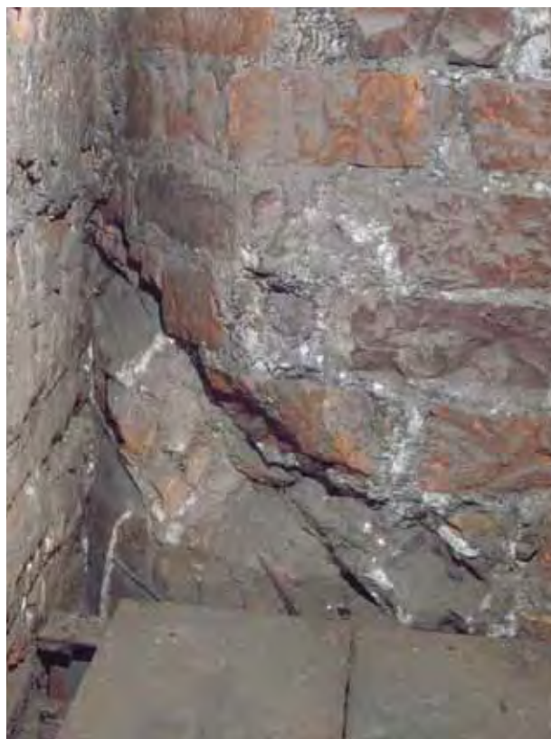
17. Kraków, kościół Świętej Trójcy, wewnątrz klatki schodowej na główny strych kościoła. Relikt oparcia sklepienia drugiej kaplicy św. Jacka wcuty w ościeże okna chóru z poł. XIII w. Po prawej lico muru skute przy usuwaniu kolistej klatki schodowej z XIV w. Fot. Daniel Podosek
