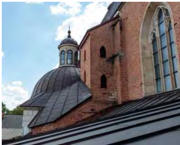
14. Kraków, kościół Świętej Trójcy, kopuła kaplicy św. Jacka i klatka schodowa na główny strych kościoła, widok na dachu nawy północnej. Fot. Daniel Podosek
