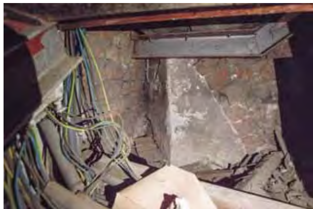
18. Kraków, kościół Świętej Trójcy, wewnątrz klatki schodowej na główny strych kościoła. Widoczne: relikty oparcia sklepienia drugiej kaplicy św. Jacka wkuty w ościeże okna, wtórne otynkowanie ościeża poniżej nasady sklepienia, po lewej mur obecnej kaplicy św. Jacka. Fot. Daniel Podosek
