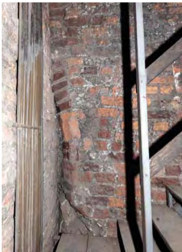
16. Kraków, kościół Świętej Trójcy, wewnątrz klatki schodowej na główny strych kościoła. Ościeże okna chóru z poł. XIII w. z wkutym oparciem sklepienia drugiej kaplicy św. Jacka. Fot. Daniel Podosek
