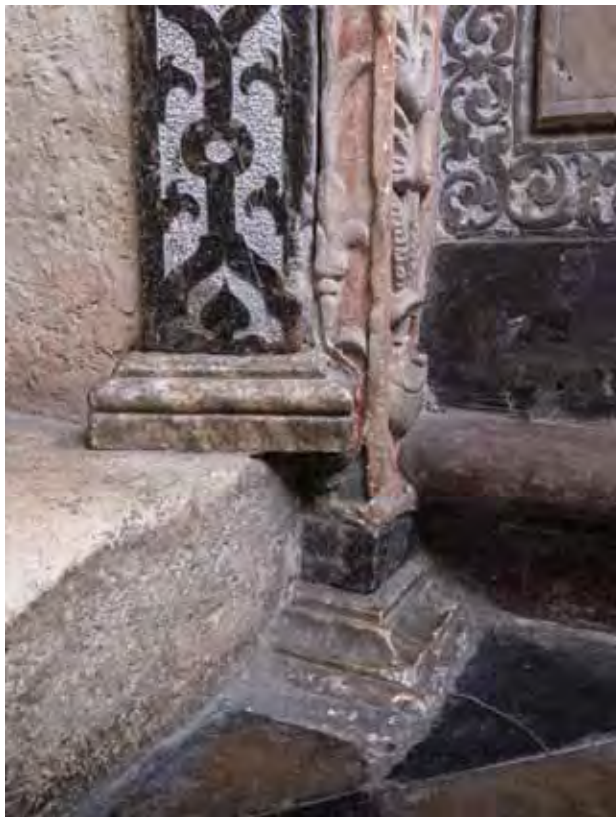
21 F. Strona północna, fragment przy progu portalu do zakrystii
