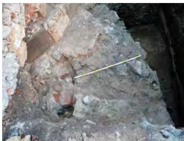
10. Kraków, kościół Dominikanów, badania archeologiczne na placu przed fasadą w 2012 r. Widoczny fundament muru obwodowego wieży południowej i wtórny charakter wypełnienia jej wnętrza. Fot. Monika Łyczak
