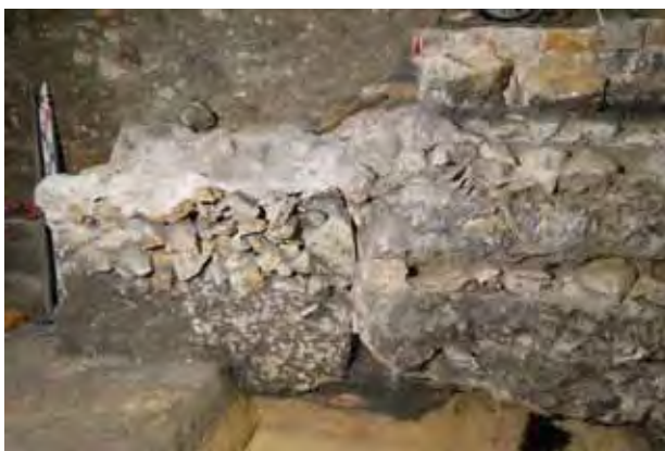
5. Kraków, kościół Dominikanów, wykop archeologiczny w nawie w 2018 r. Dwa odcinki muru o przebiegu północ-południe łączone na styk. Fot. Monika Łyczak
