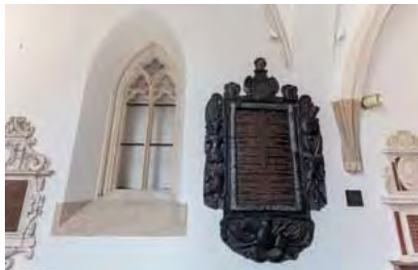
15. Kraków, klasztor Dominikanów, krużganek pierwszego wirydarza. Widok na północną elewację nawy północnej, z zamurowanym oknem doświetlającym pierwotnie północne przęsło lektorium oraz wspornikiem i żebrami sklepienia krużganka. Fot. Daniel Podosek
