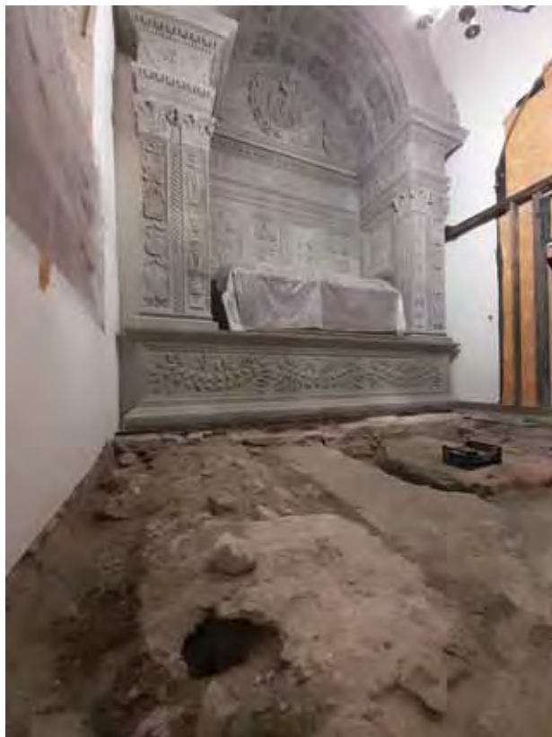
1. Archikatedra, kaplica Jana Olbrachta w trakcie prac, po zdjęciu posadzki. Fot. Maciej Wilamowski
