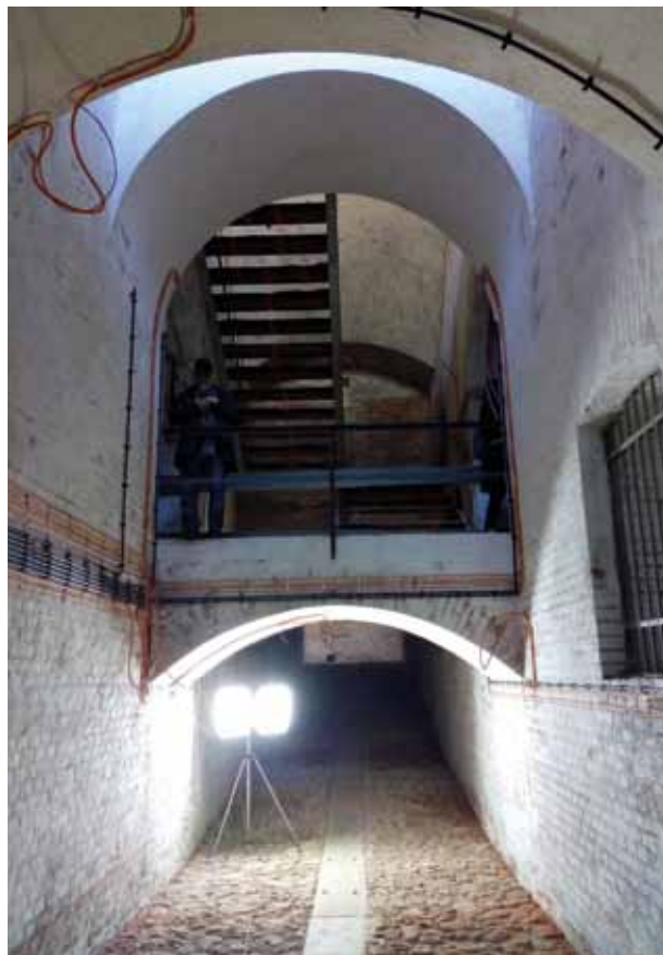
8. Fort artyleryjski nr 52 „Borek” w trakcie prac remontowo-konserwatorskich. Fot. Artur Chojnacki
