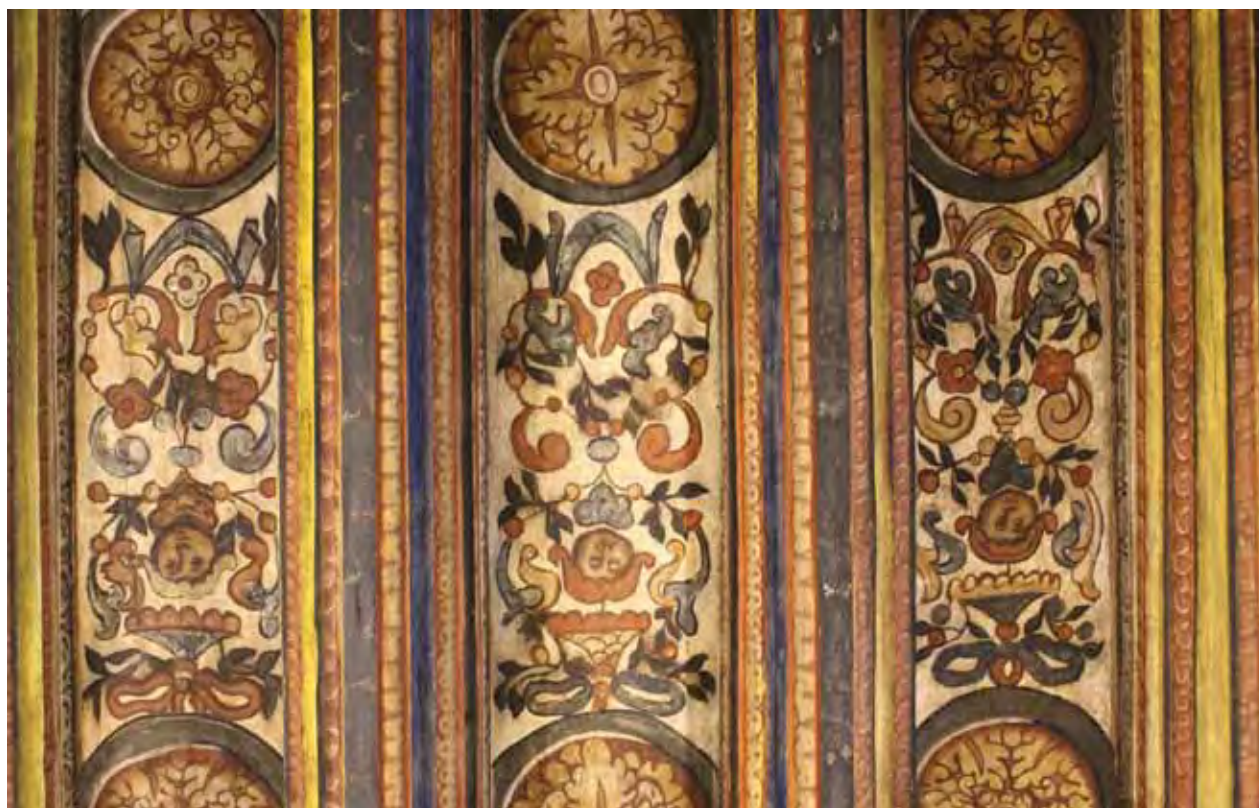
4. Drewniany strop po konserwacji w pomieszczeniu na I piętrze w siedzibie Towarzystwa. Fot. Katarzyna Feć-Sfora
