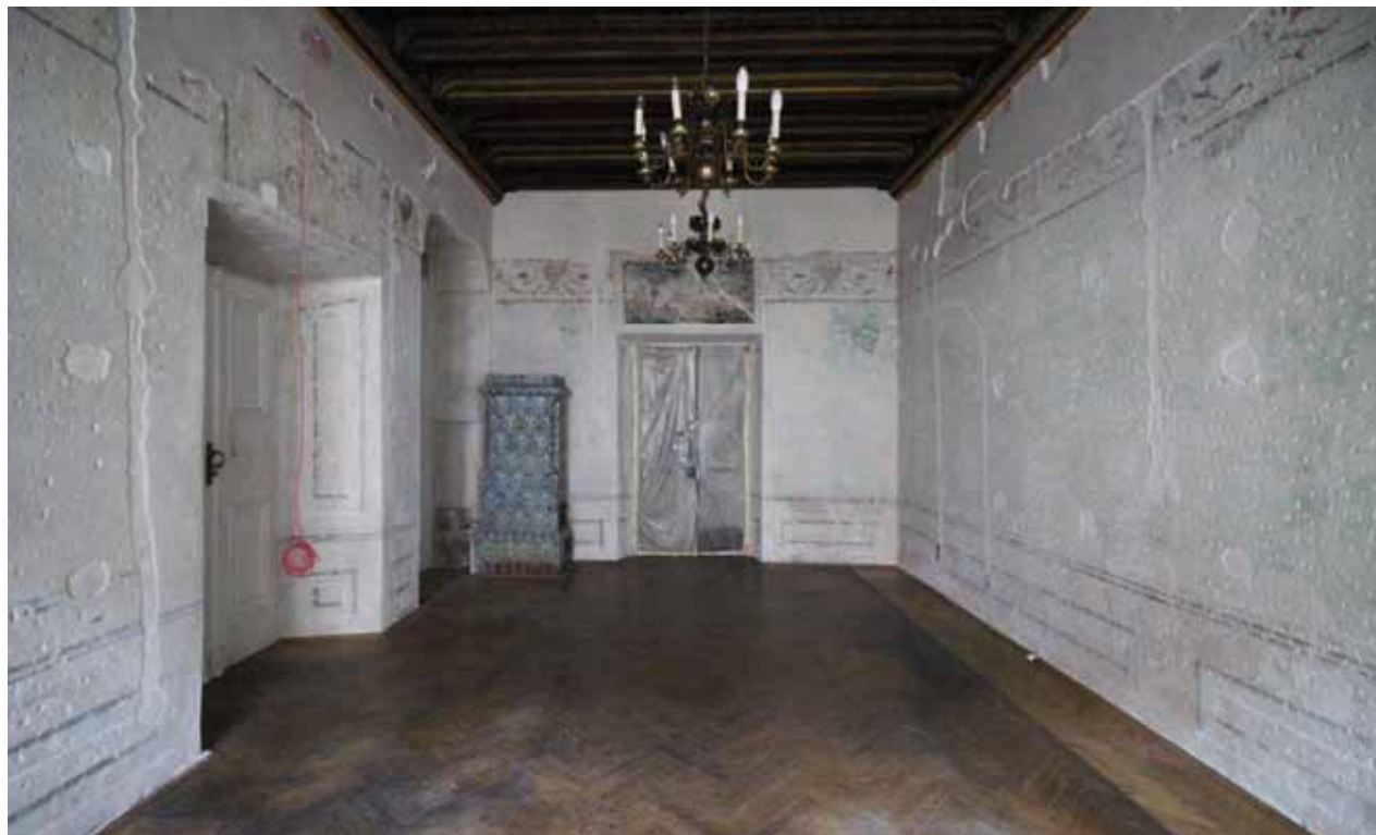
3. Pomieszczenie na I piętrze kamienicy przy ulicy św. Jana 12, w siedzibie Towarzystwa: w trakcie remontu konserwatorskiego na ścianach odkryto i zabezpieczono polichromie z XVIII–XIX w., został też odnowiony zabytkowy piec kaflowy. Fot. Katarzyna Feć-Sfora
