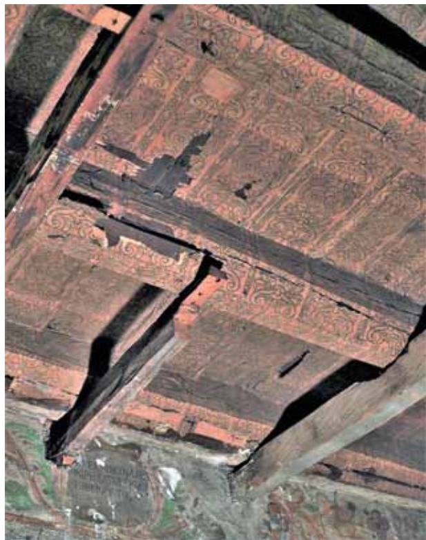
5. Konstrukcja z przełomu stuleci XVIII i XIX, podtrzymująca sufit ramowy, i uzupełnienia ubytków kołtryn papierem marmurkowym. Fot. Paweł Pencakowski
