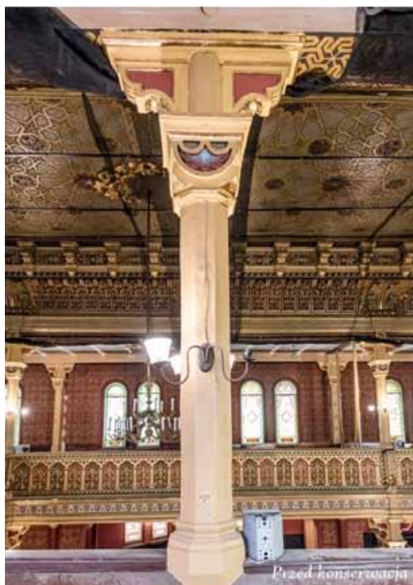
12. Synagoga Tempel, podpora galerii dla kobiet przed i po konserwacji. Fot. Henryk Pachla
