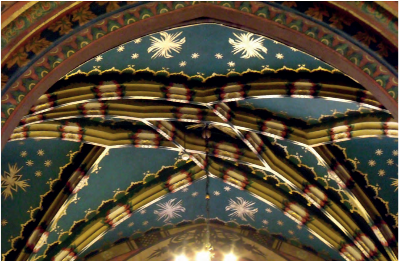
3. Kraków, kościół Mariacki, sklepienie w kaplicy Archaniła Michała. Fot. P. Knapik
