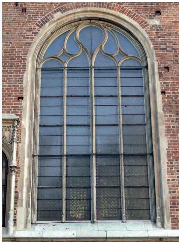
12. Kraków, kościół Mariacki, maswerk w oknie kaplicy św. Wawrzyńca. Fot. P. Knapik
