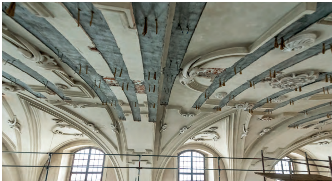
12. Synagoga Izaaka, sklepienie w trakcie prac zabezpieczających. Fot. Henryk Pachla
