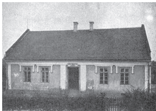
Pierwszy murowany budynek szkoły w Bachowicach
