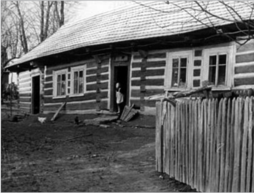
Dwutraktowa chałupa z poł. XIX wieku pokryta powtórnie cementową dachówką należąca do Józefa Starowicza z Ryczowa.
