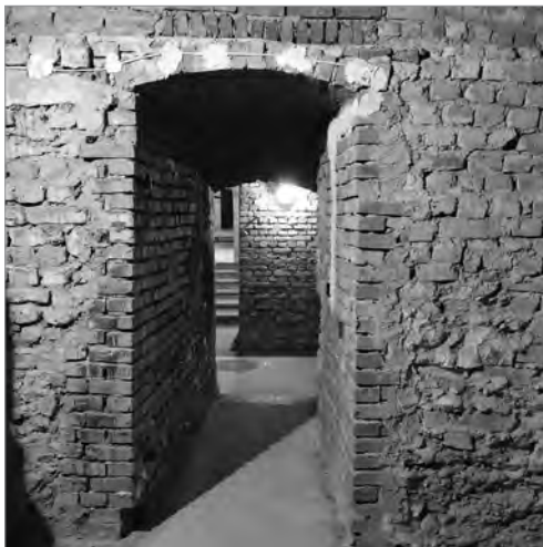
Fot. 4. Piwnice zamkowe ukazują grubość murów utrzymujących budynek, 2023 r. Źródło: fot. Barbara Sołtys
