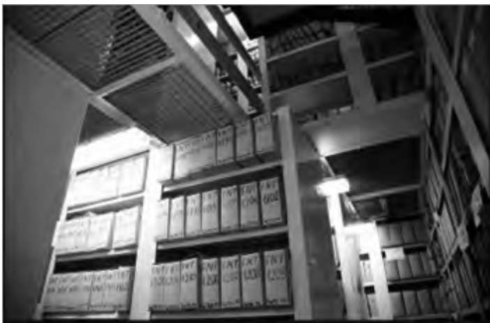
Fot. 5. Kratownica w magazynie nr 212 pozwalająca wykorzystać regały w wysokim pomieszczeniu, 2014 r. Źródło: fot. Małgorzata Multarzyńska-Janikowska
