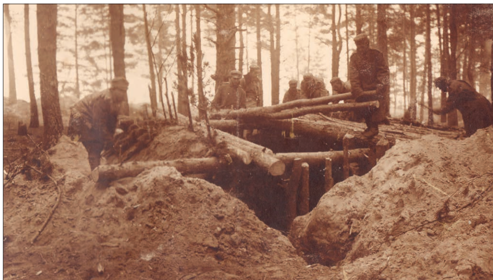
Budowa ziemianki pod Optową na Wołyniu
