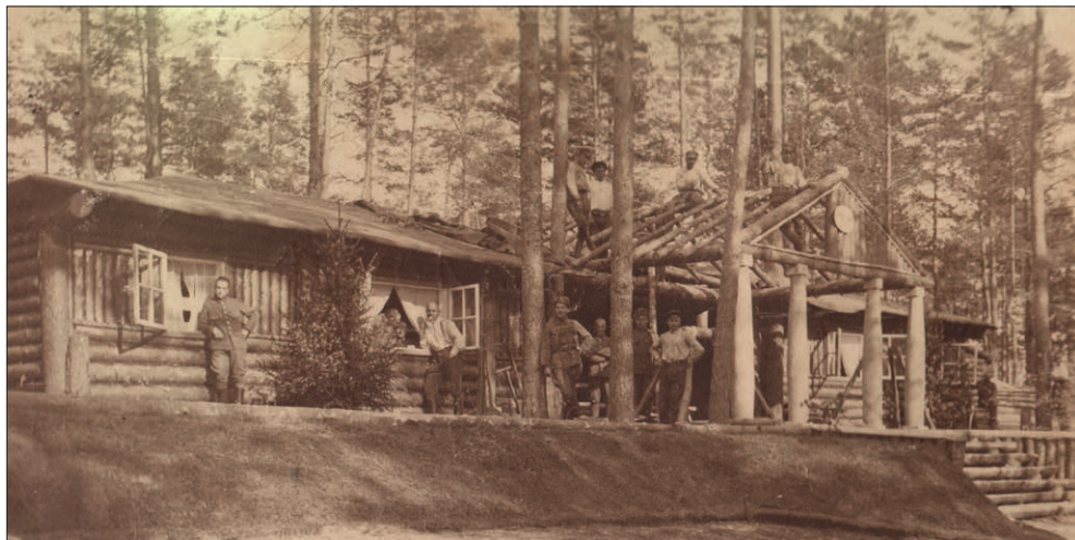
Budynek Komendy 1 pp LP pod Optową
