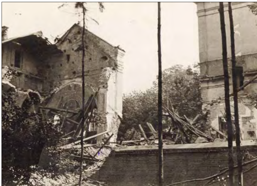
Zawalone sklepienie i wieża kościoła Jezuitów we Lwowie – wrzesień 1939 (fot. S. Bałuk)
