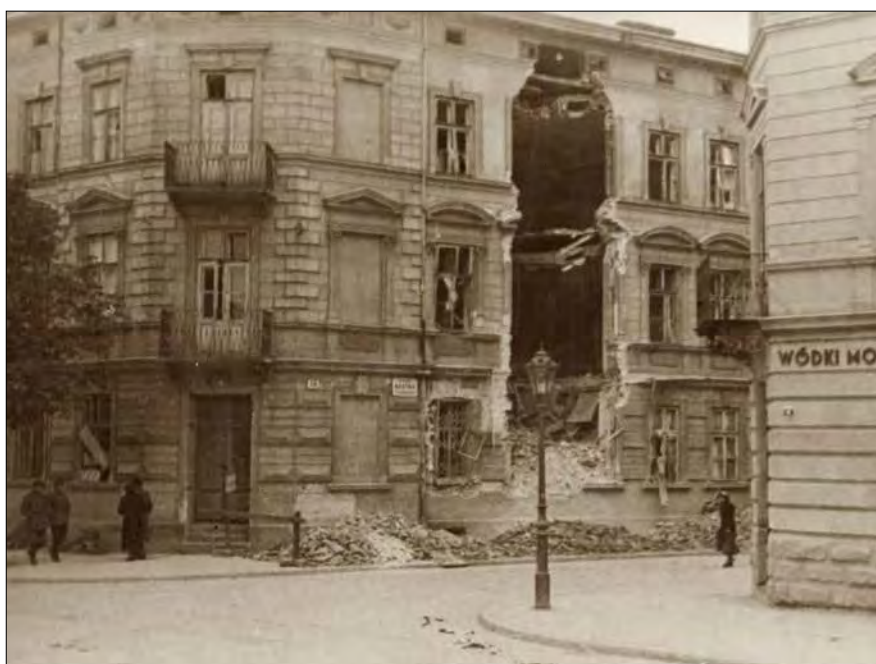
Zbombardowana kamienica przy ul. Krótkiej (róg ul. Gródeckiej i Pierackiego) we Lwowie – wrzesień 1939 (fot. S. Bałuk)
